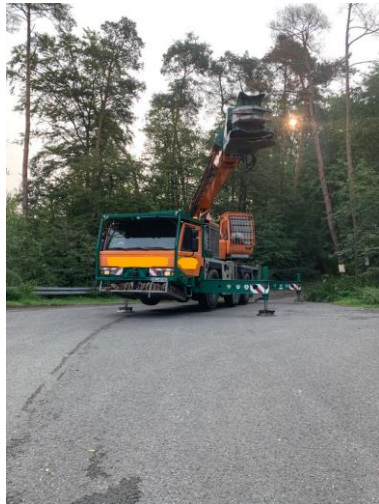
Fällkran bei Verkehrssicherung an der A3
