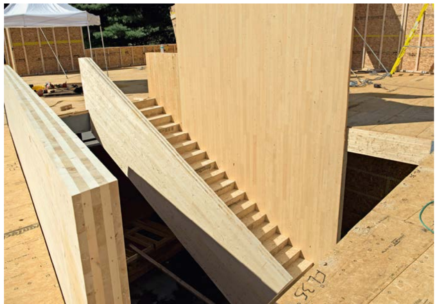
Einsatz von CLT-Elementen beim Hausbau.
