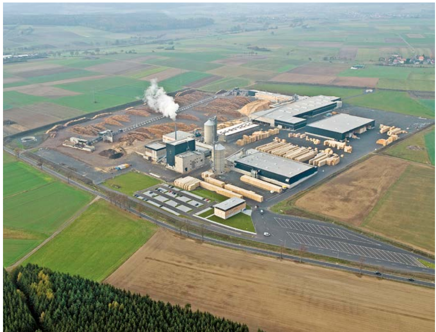
Blick auf den Standort Pfeifer Holz Lauterbach.
