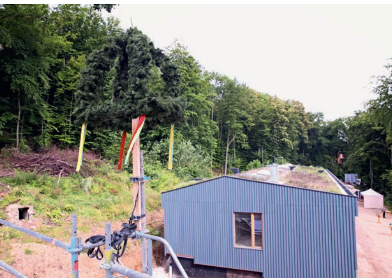
Ansicht Gebäude B
