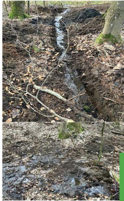
Beim Ausbaggern des Zulaufrohres entstandener und später wieder verfallter Graben sowie Quellbereich anstelle der ehemaligen Sickergrube
