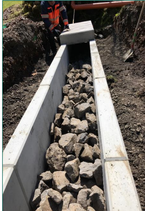
Abbildung 9: Bau eines offenen U-Profils
