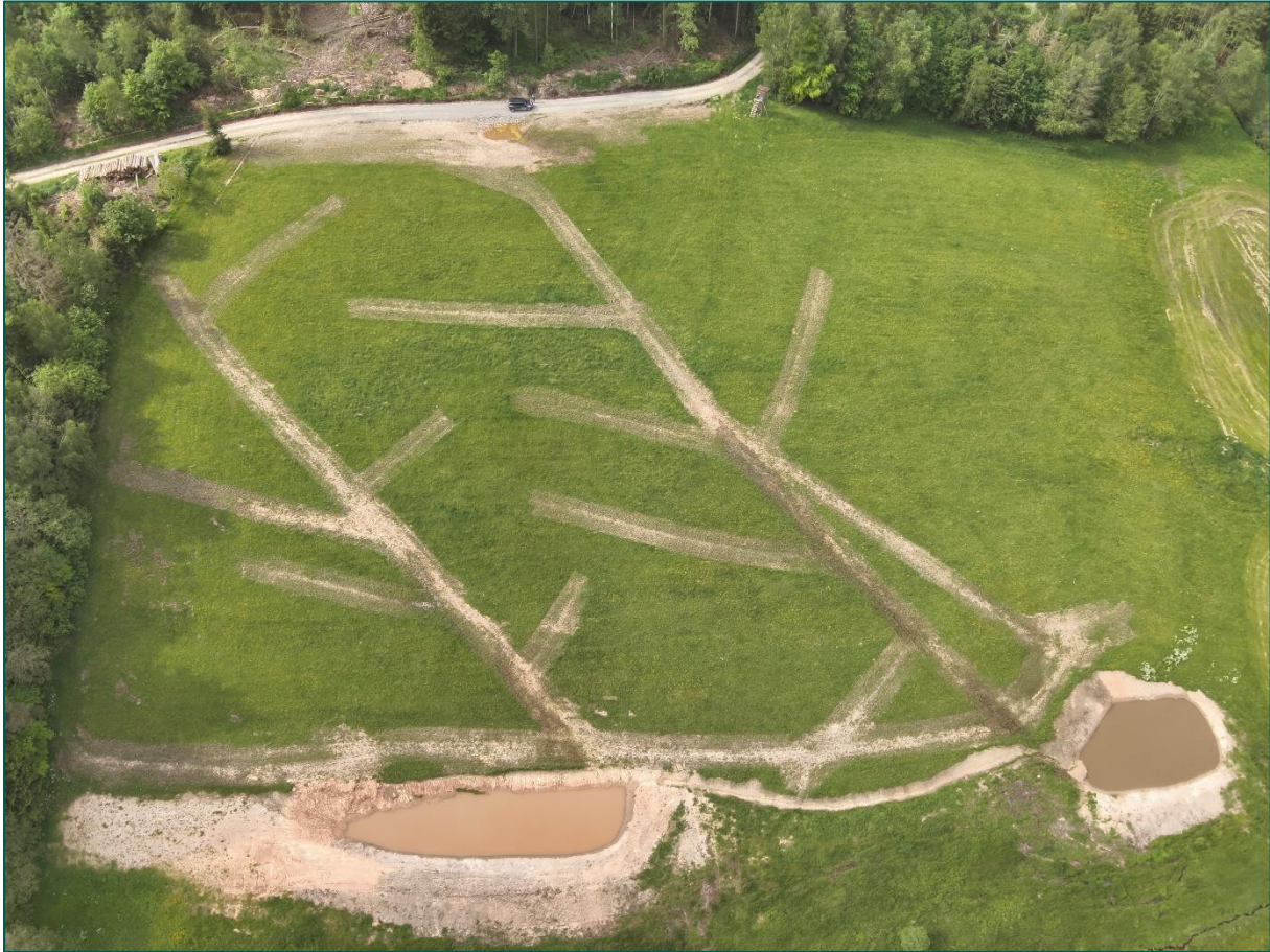
Abbildung 17: Rückbau von Drainagen in Verbindung mit der Anlage neuer Teiche
