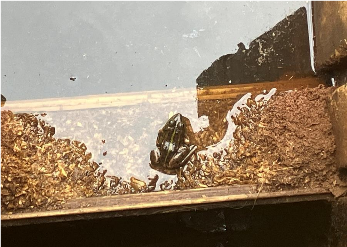
Abbildung 7: Teichfrosch auf Staubrettern eines Mönches. Das Sägemehl zwischen den Brettern dichtet den Mönch ab und staut so das Stillgewässer an (Foto: Annika Wilbers 2024).
