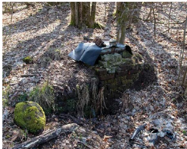
Abbildung 13: Gefasste Kalbachquelle: An der Oberfläche mit nur geringer Ausprägung, unterirdisch jedoch großes Sammelbecken © Stefan Zaenker
