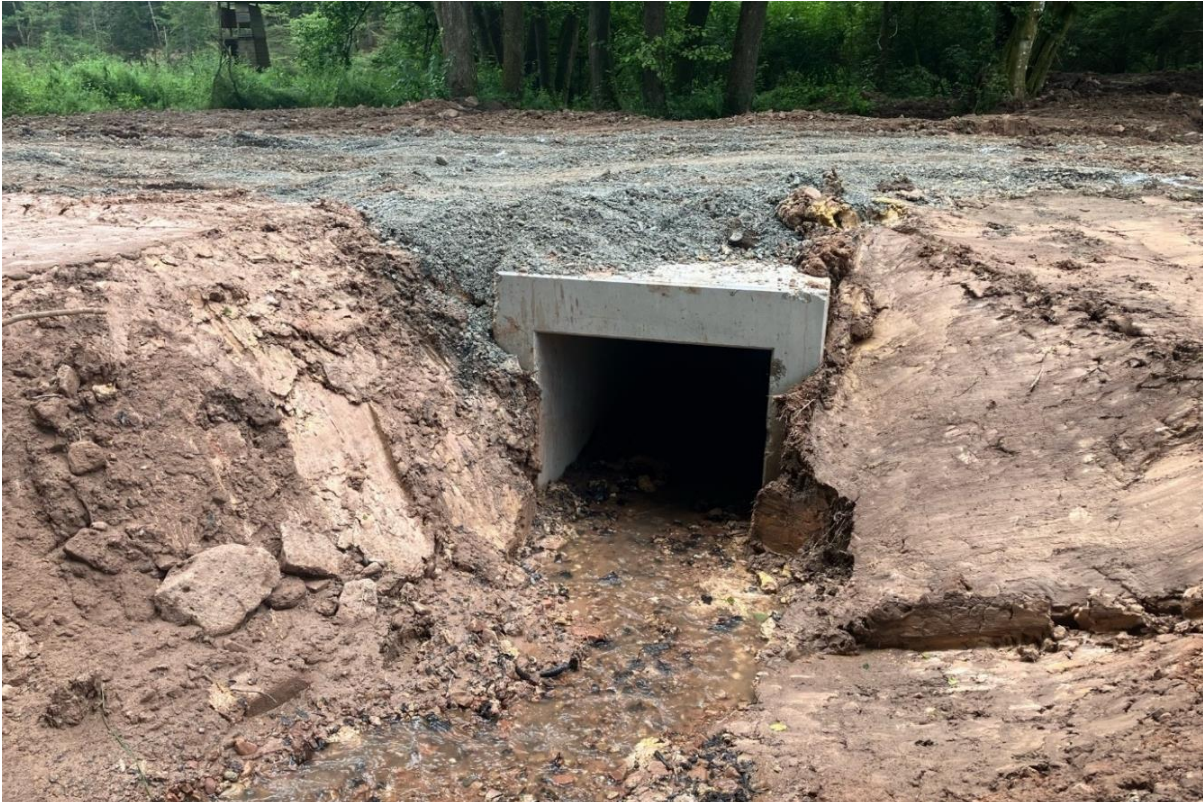
Abbildung 6: Offene Gewässersohle zur Verbesserung der Durchwanderbarkeit im Revier Breunings
